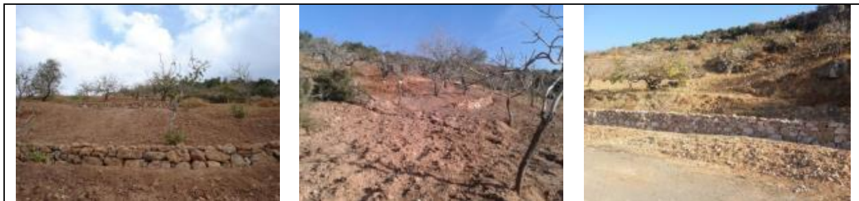
Resim 15: Örnek bahçelerde yapılan teraslama ve istinat duvarı
