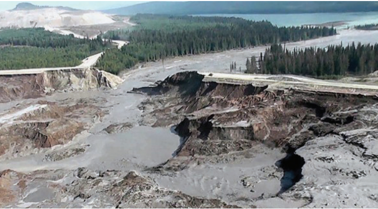
Foto 17 Atık maden barajı yıkılmış seddesinden bir görüntü. Polley Dağı-Kanada, 4 Ağustos 2014
