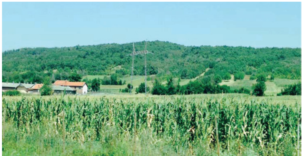
Postojeći dalekovod jačine 400 kV duž Transbalkanskog koridora
