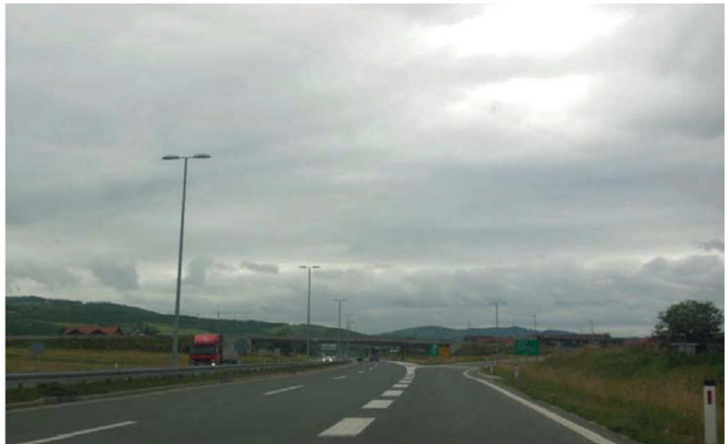
Modernizovana petlja na Koridoru CVc u Bosni i Hercegovini.
