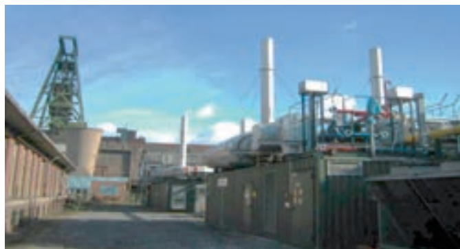
Рисунок 9.2 Электростанция в Лоберге
