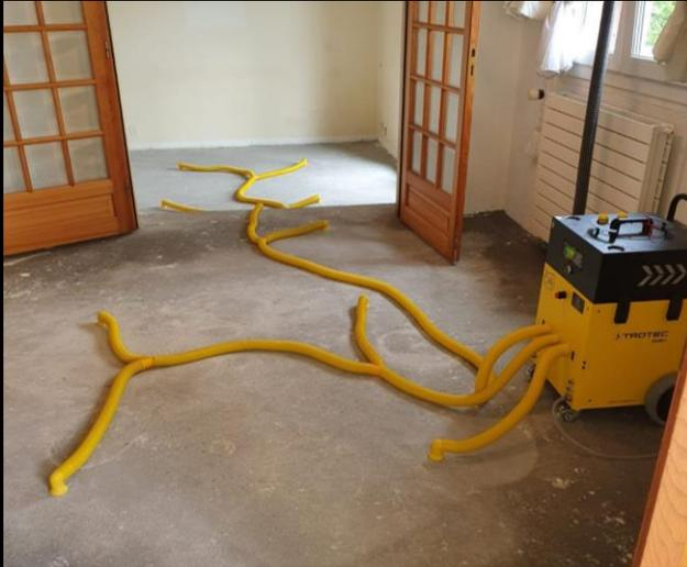
Permet l'assèchement de l'eau ou de l'humidité se situant entre la dalle et la chape ou dans un doublage mural (isolation) par aspiration ou insufflation d'air.
