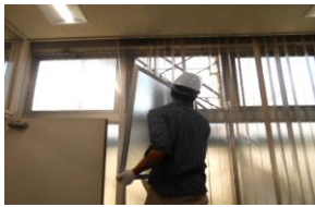
上部排煙窓ペアガラス化
