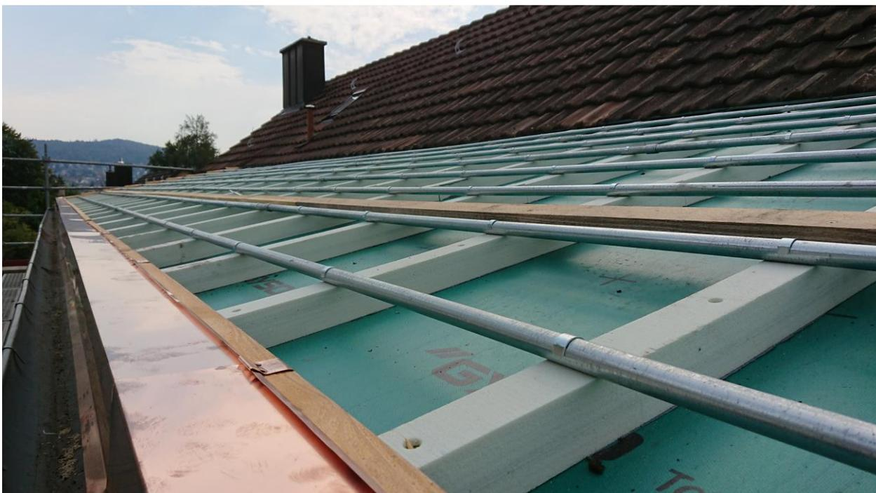
Gerade bei kritischen Anschlüssen ans Unterdach (Unterdach für ausserordentliche Beanspruchung, Unterschreitung der Mindestneigung des Eindeckungsmaterials) und bei Anschlüssen an Einlegerinnen sowie innenliegende Rinnen kann diese Lösung einen dichten, langlebigen Anschluss generieren. Das System erfüllt, nach den geltenden Produktnormen für Unterdächer der EN12390 die Wassereinwirkungsklasse W1.
