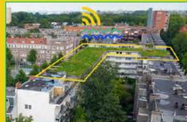
ROOF 6 (DE ALLIANTIE)
