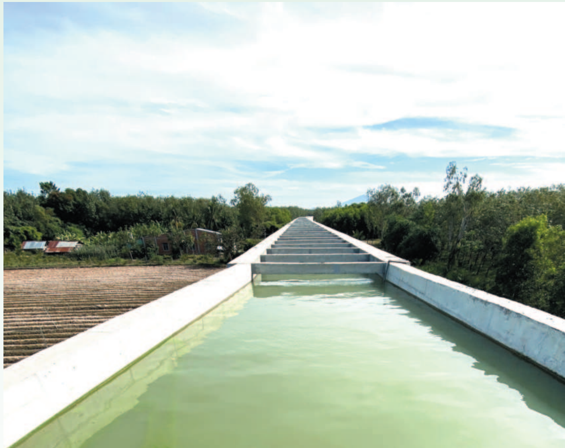
Dự án kênh chính đi qua khu vực xã Ninh Điển, huyện Châu Thành
