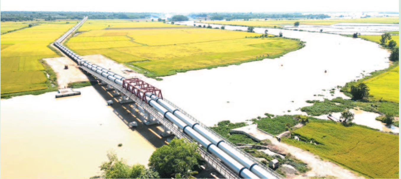
Đường ống dẫn nước vượt sông Vàm Cỏ Đông
