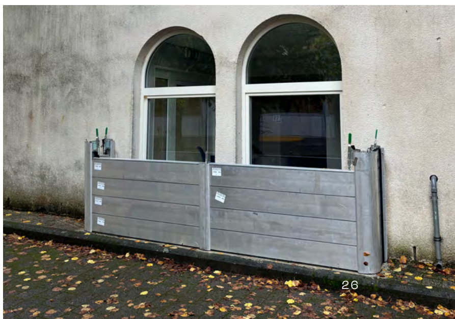
Mobile Hochwasserschutzwand am Centre Princesse Amélie
