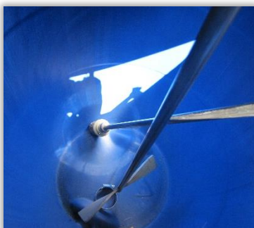
Rys. 59 i 60. Filtr ssawny (bliżej) zamocowany do sztywnego przewodu cieczowego (59) oraz filtr i mieszadło mechaniczne cieczy na dnie zbiornika (60).
