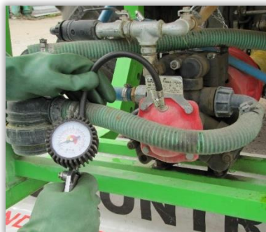
Rys. 31. Sprawdzenie ciśnienia w powietrzniku za pomocą manometru zamontowanego na przewodzie ciśnieniowym pompy lub sprężarki.
