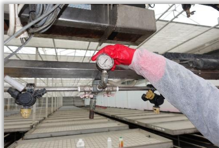
Rys. 38. Kontrola stanu technicznego manometru.
