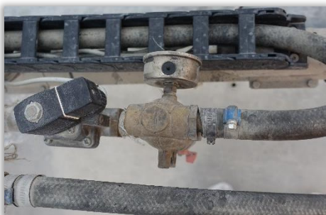
Rys. 46. Sprawdzanie jakości połączeń układu cieczowego.
