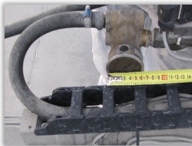
Rys. 35. Pomiar średnicy obudowy manometru.
