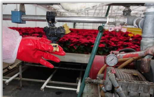
Rys. 20. Korpus obracalny rozpylaczy.
