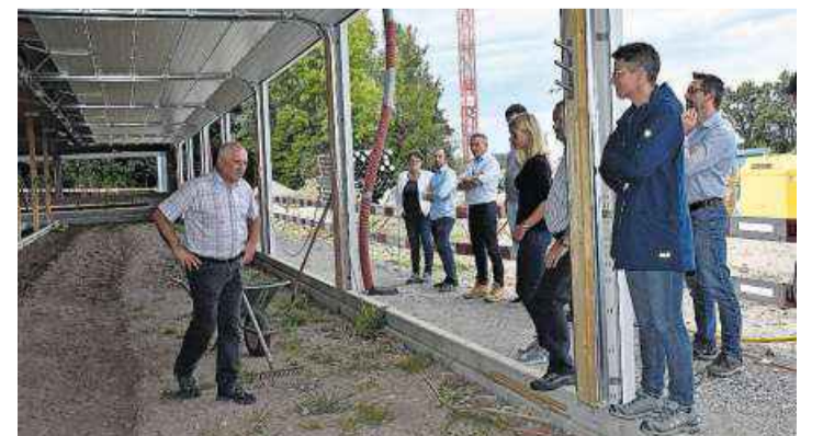
Josef Huwiler (links) führte durch die Baustelle. Bild: Melanie Burgener
