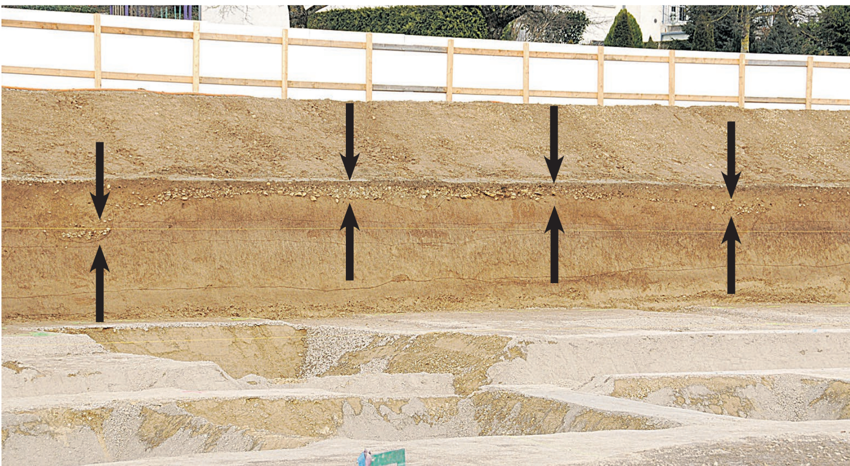
Ein Blick auf den Querschnitt: Nur Experten erkennen auf Anhieb die wenige Zentimeter hohe Erdschicht mit der alten, auf die Seite abfallenden Römerstrasse.
