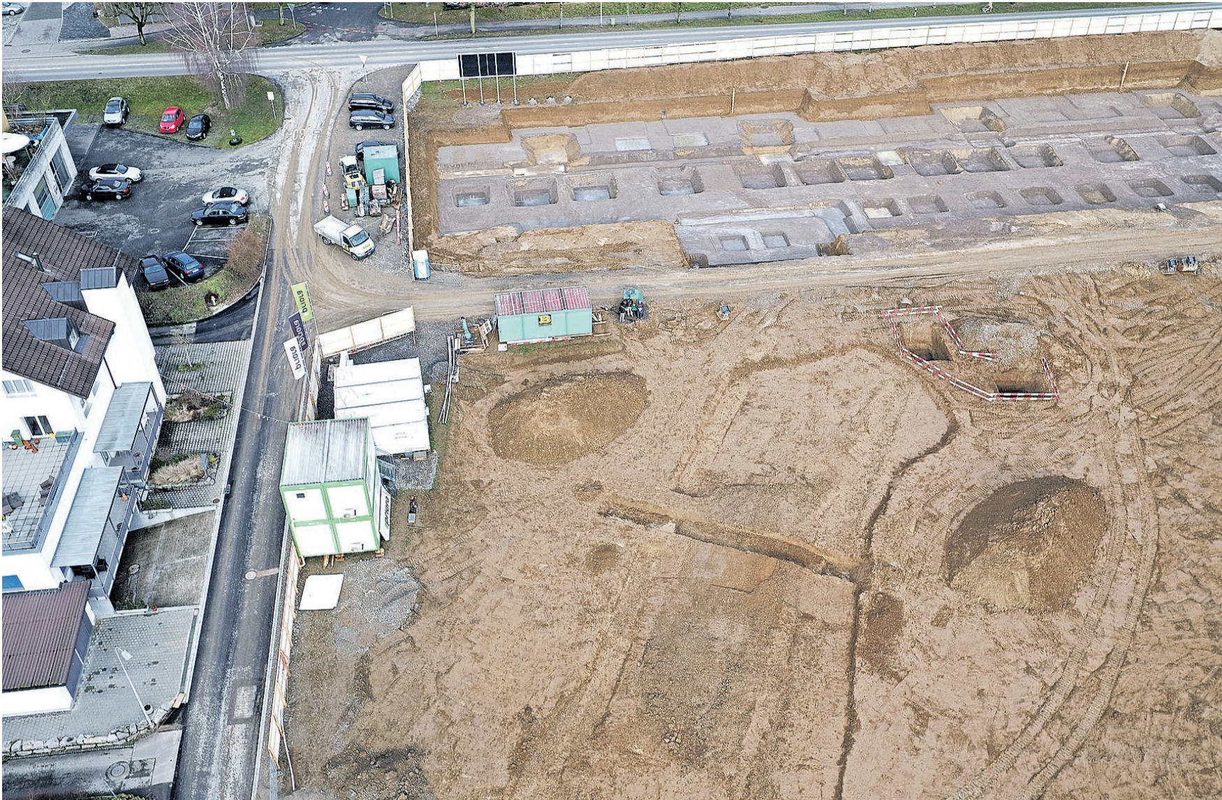
Die Luftaufnahme von Jarek Piech (Firma «ArchFlyTech» aus Döttingen) zeigt den Gesamtverlauf der Römerstrasse aus der Vogelperspektive. Links oben im Bild die Garage Bugmann, am oberen Bildrand die Surbtalstrasse und die bereits erstellten Baugruben für die Überbauung «Riedholzblick».
