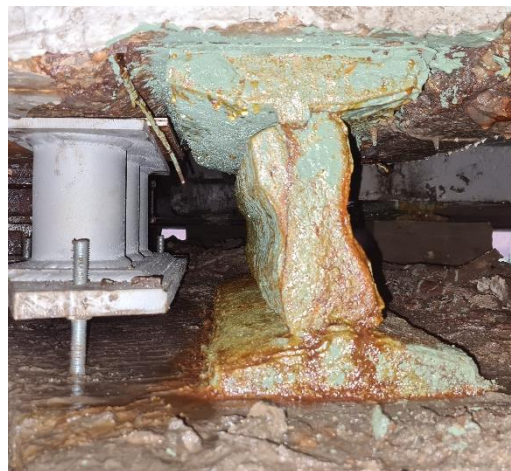
Figura 5-2 – Difetto su Apparecchio di appoggio
