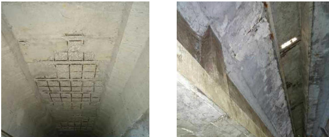
Figura 5-1 – Difetti sulle solette e sbalzi
