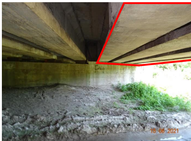
Figura 3-5. Vista intradosso impalcato: secondo impianto
