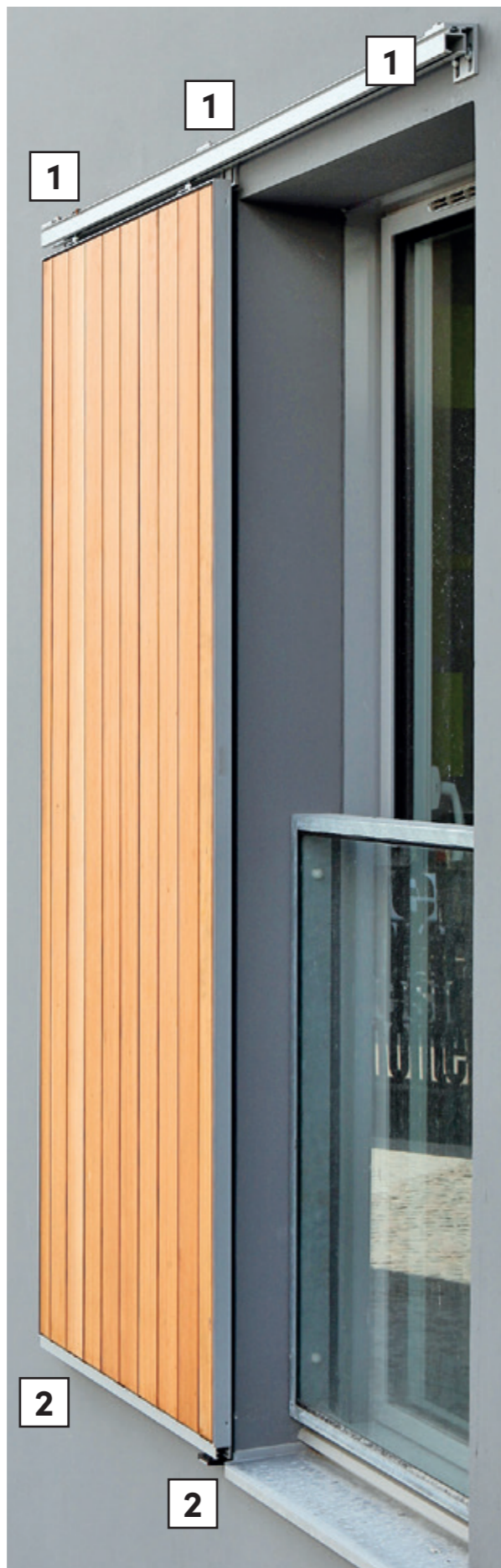
2 | Befestigung Schiebeläden
