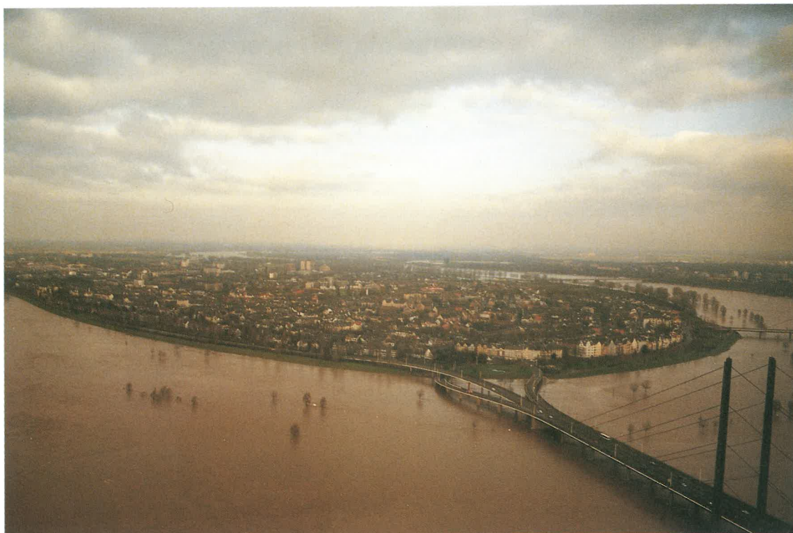
Crue de 1995 dans la zone de Düsseldorf, quartier d'Oberkassel (Photo: STUA Krefeld)
