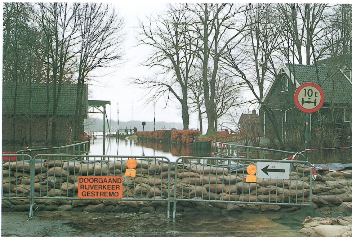
Mesures de protection contre les inondations sur le terrain aux Pays-Bas
