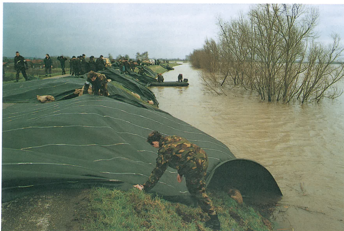
Travaux de consolidation des digues á Ochtem/Pays-Bas en 1995
