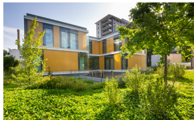
Das Gebäude der Radio-Onkologie ist nach Minergie-Standard zertifiziert.
