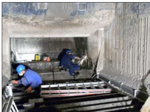
Revisionsarbeiten am Rost der OL 3
