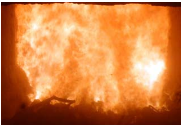
Blick in den Feuerraum
