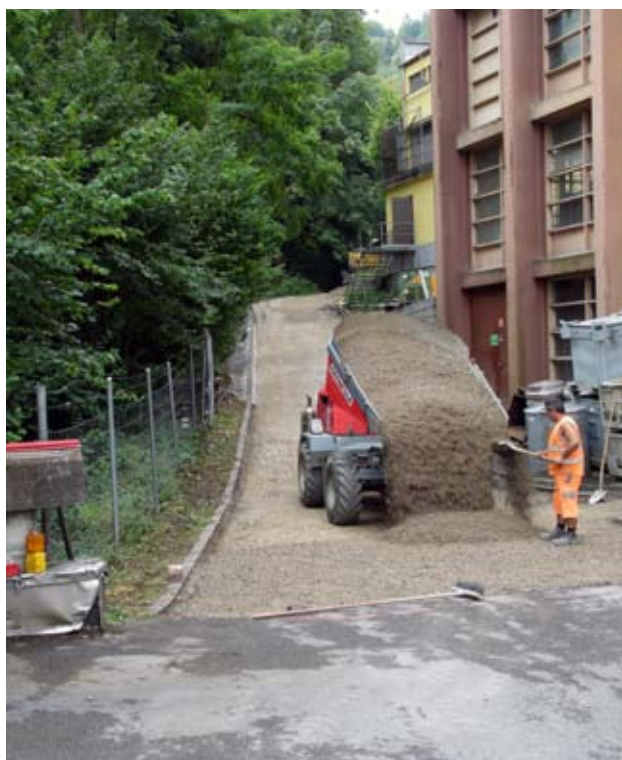
Sanierung der Zufahrtsstrasse zur Werkstatt
