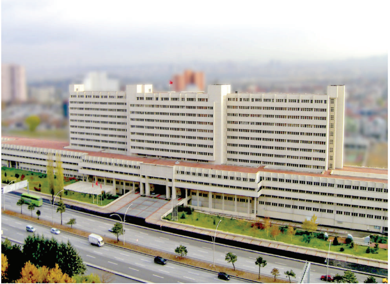
Sayıřtay Hizmet Binası
