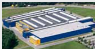
Hörmann KG Eckelhausen, Allemagne
