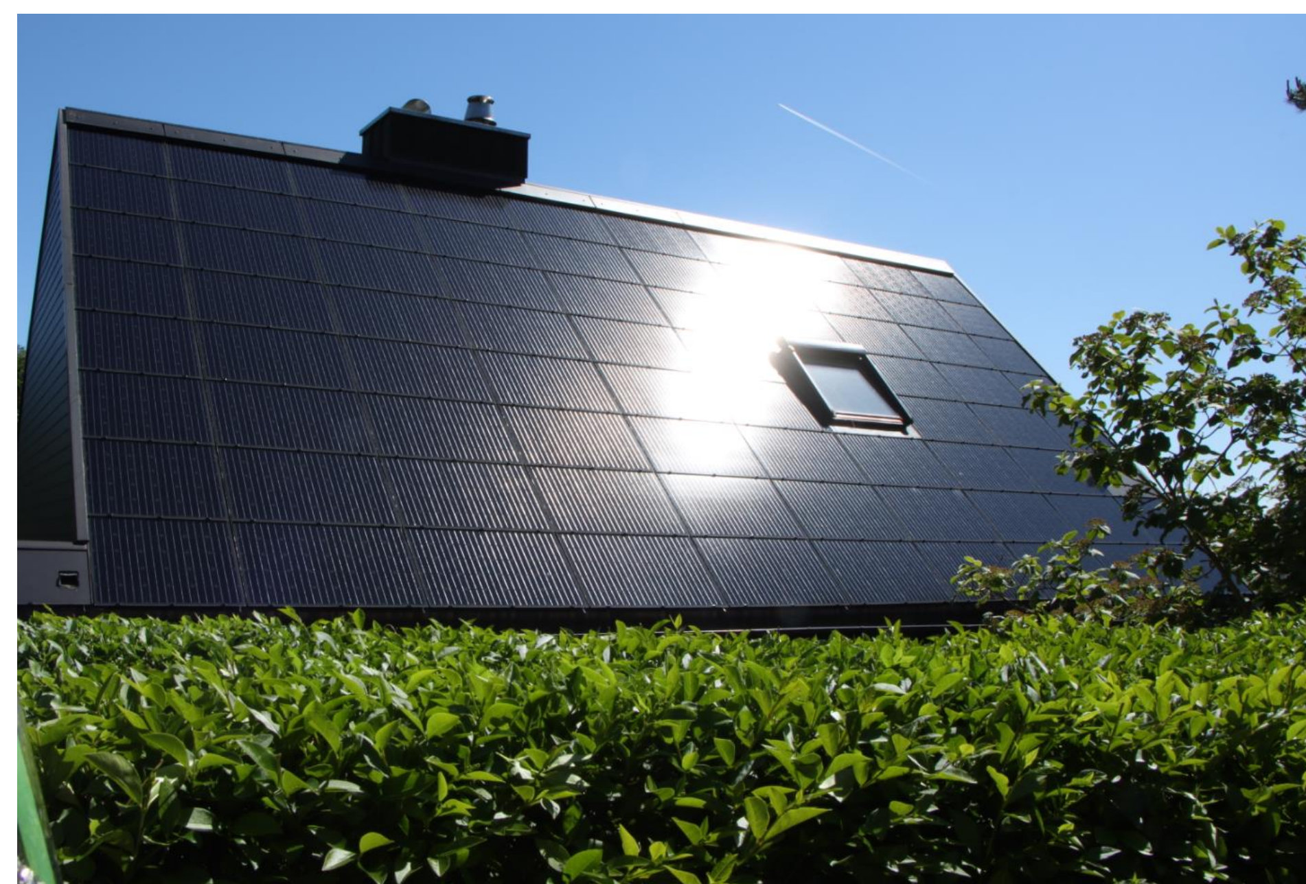
Abbildung 4: Dachfläche vor der Sanierung
