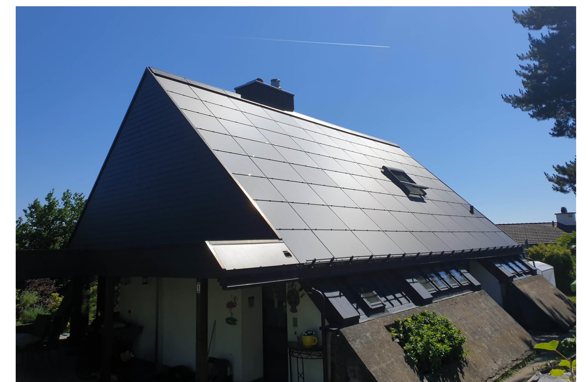
Abbildung 6: Dachfläche nach der Sanierung
