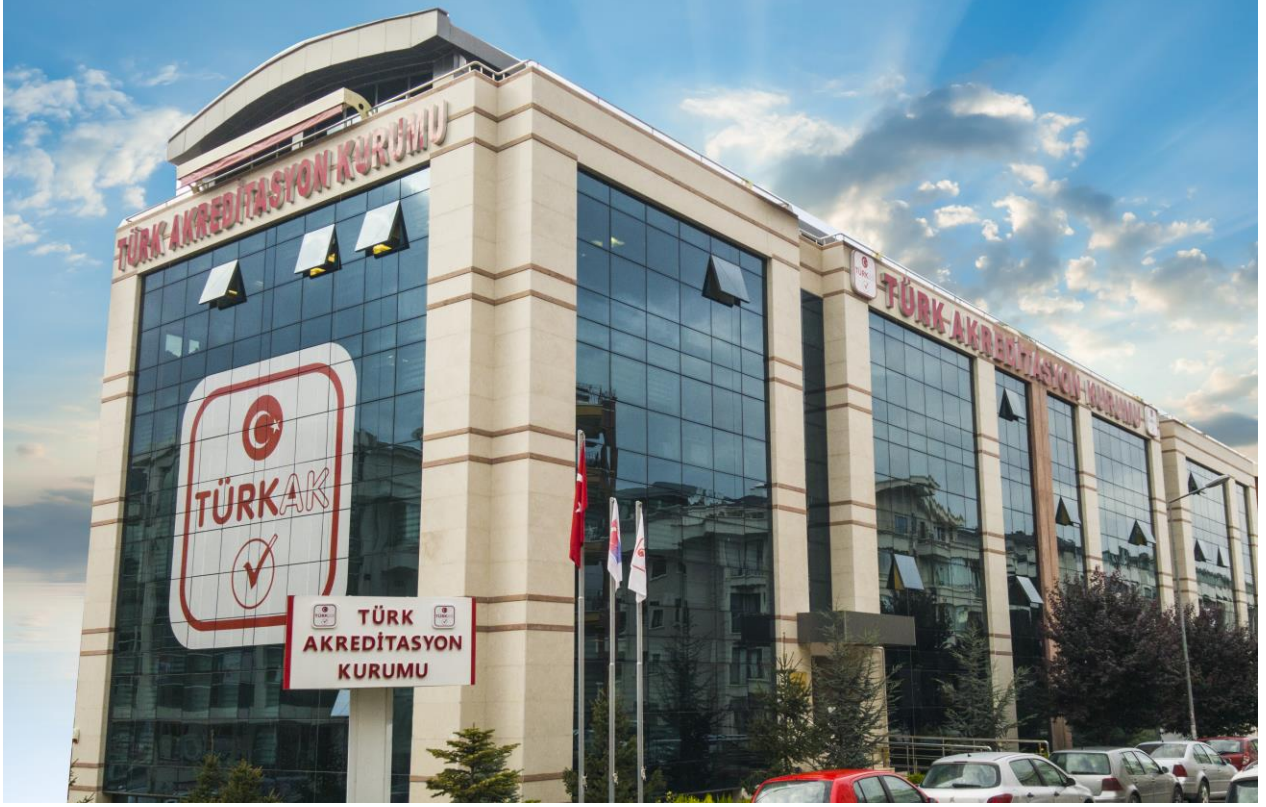
Resim 1: TÜRKAK Hizmet Binası Görünümü
