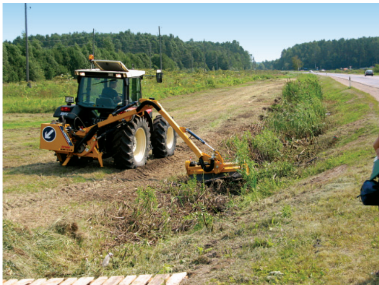
13. att. Grāvmalu (nogāžu) applaušana, izmantojot traktortehniku (A. Ojukalna foto)
