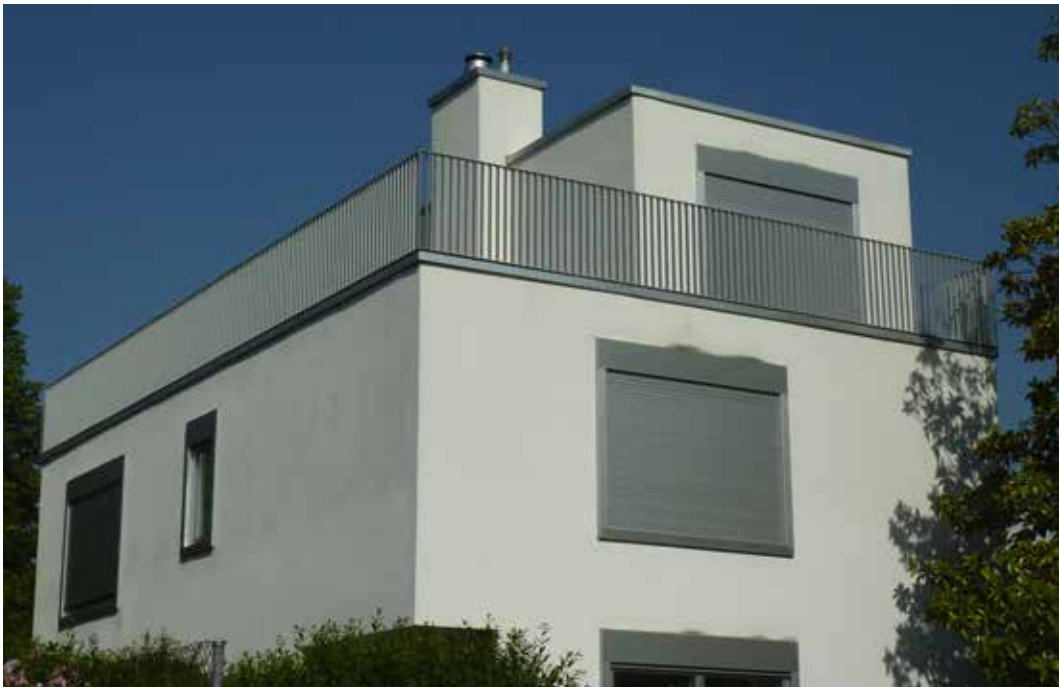
Terassengeländer, Arabienstrasse, Basel
