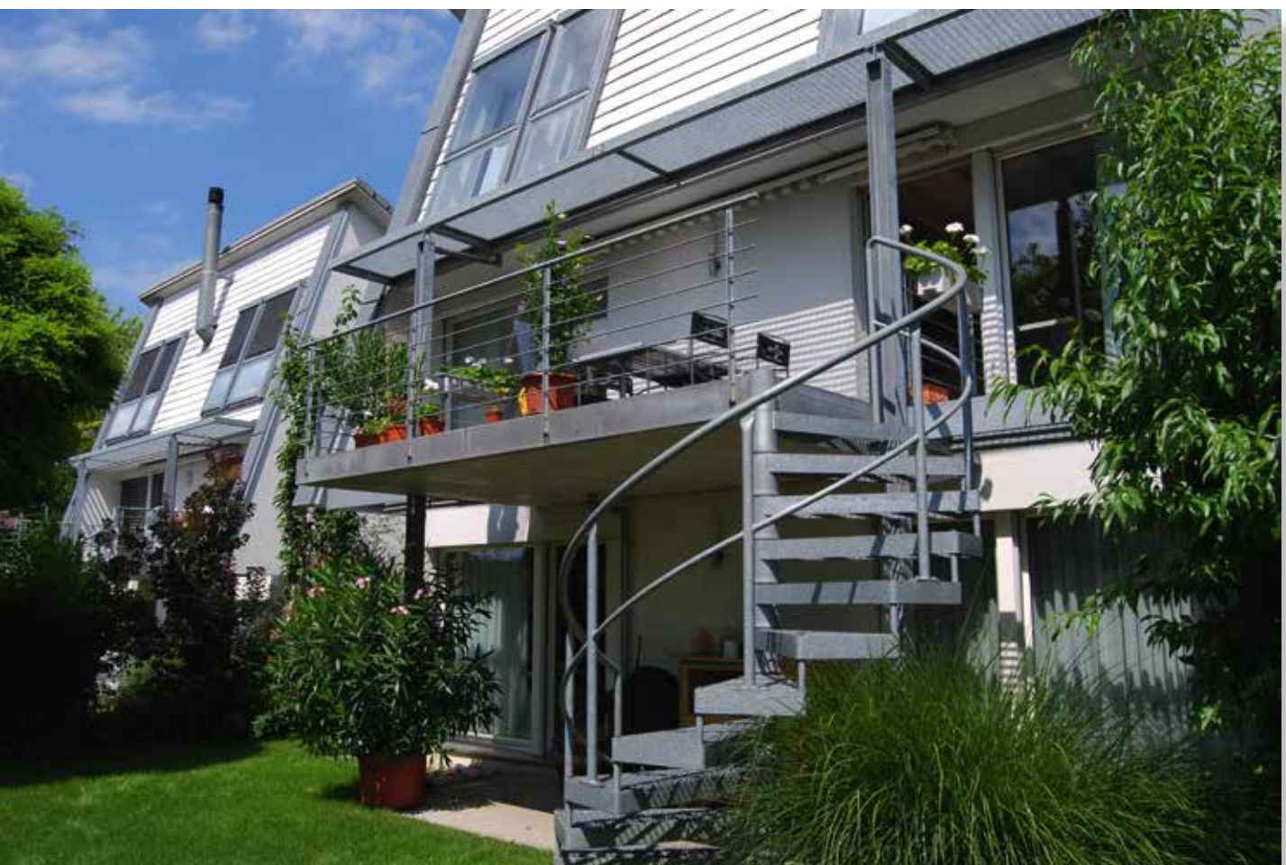
Terassenkonstruktion, Passwangstrasse, Therwil
