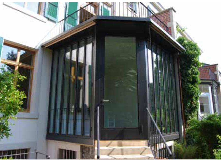
Terassenverglasung, Angensteinerstrasse, Basel
