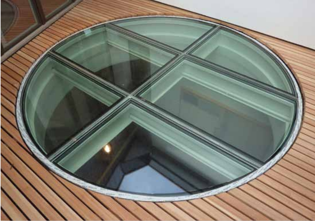
Begehbares Terrassenoblicht, Bättwilerstrasse, Basel
